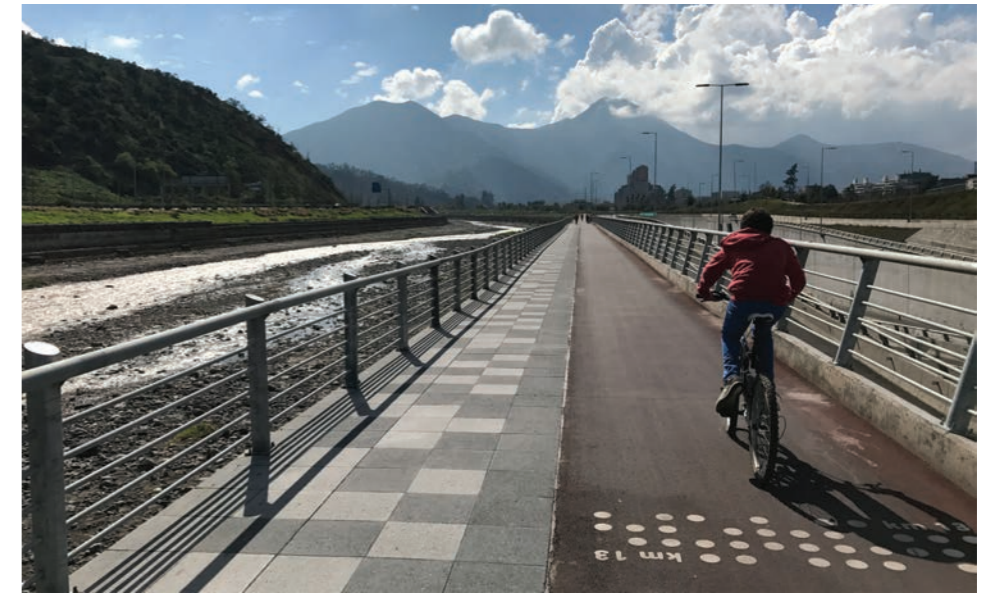
VIADUCTO EXISTENTE BORDERÍO
