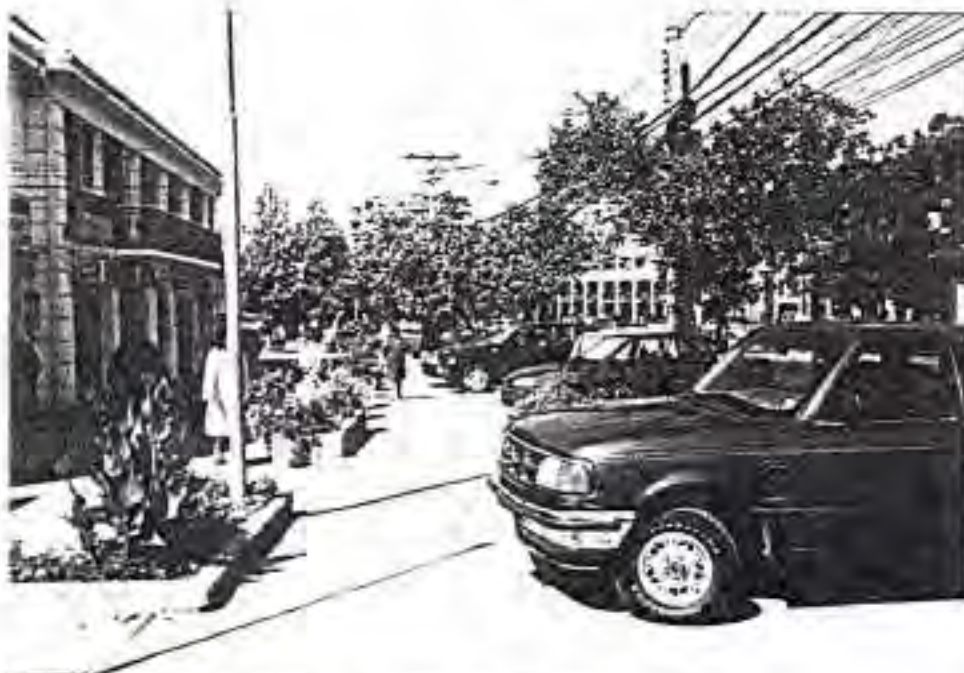
Imagen típica del desorden en el espacio público del tramo. Invasión de estacionamientos sobre la vereda, indefinición del límite entre espacio público y privado, tendido aéreo.
