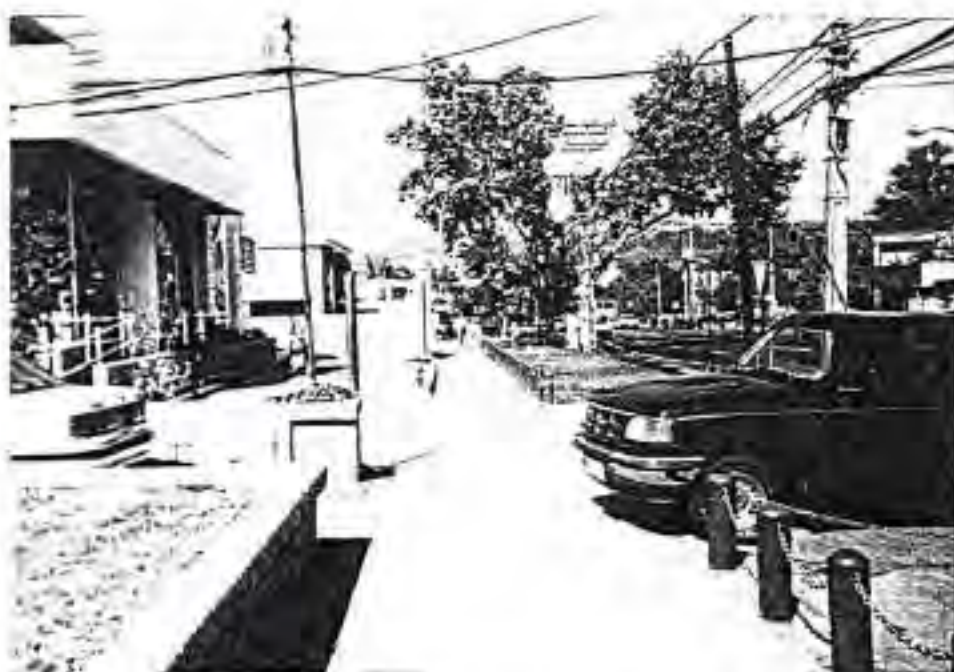
Discontinuidad del pavimento, estacionamientos sobre la acera, falta de equipamiento, irregularidad de la arborización la que también es víctima del tendido aéreo de cables.
