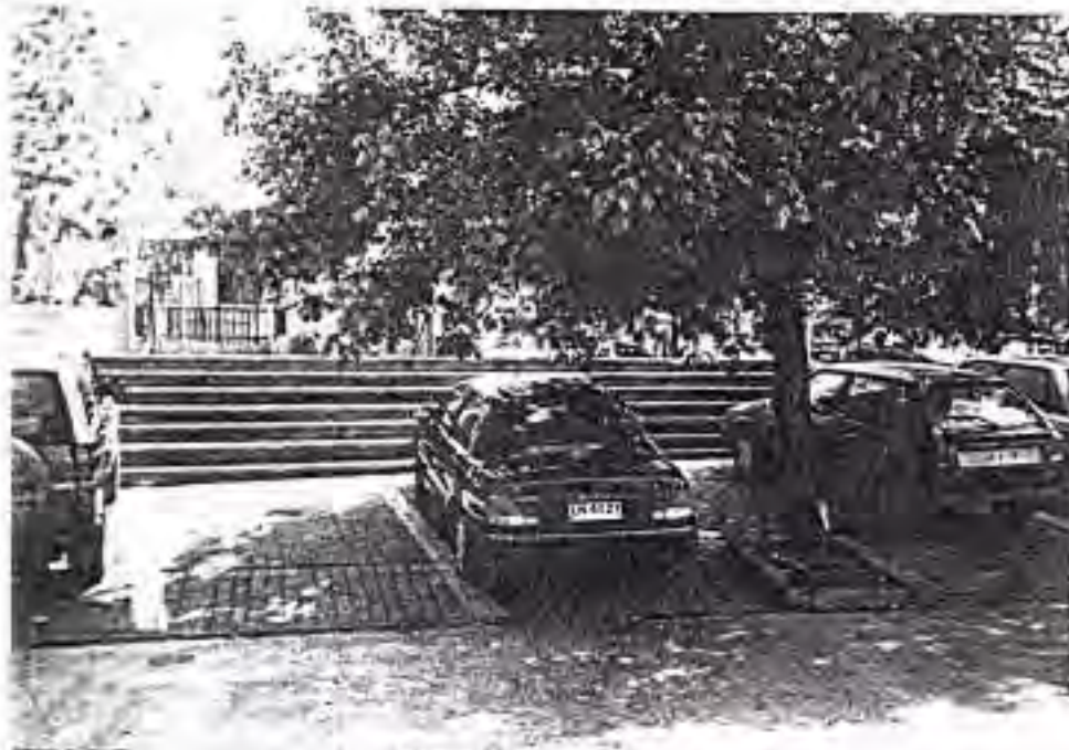
Desniveles en la vereda, la continuidad peatonal se ve interrumpida además por estacionamientos.
